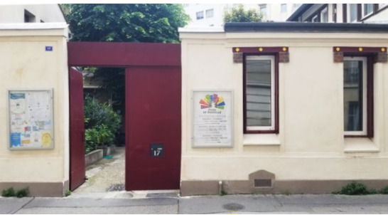
Le mur et le portail ont été refaits
