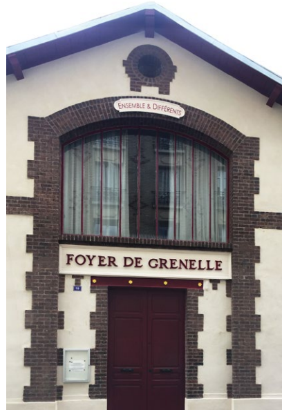
Nouvelle architecture de la salle polyvalente, façade du temple, côté rue
